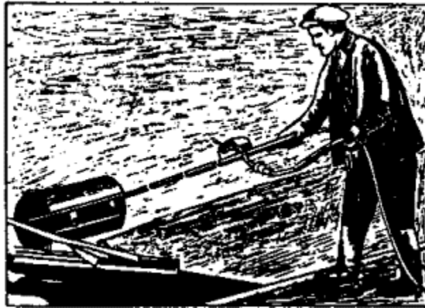
Рис. 3. Устройство асфальтовой стяжки
