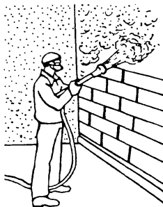
Рисунок 2 - Последовательное нанесение слоев обрызга, грунта
