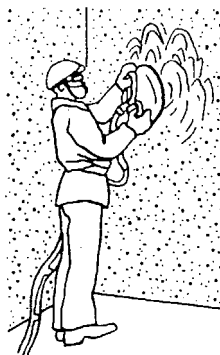
Рисунок 4 - Механизированная затирка поверхности
