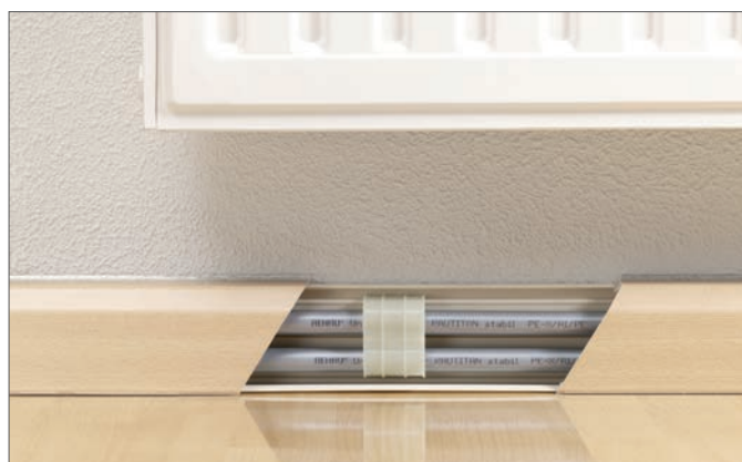
Рис. 16-24 Фиксация труб отопительной системы в плинтусном канале RAUSOLO
