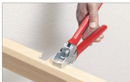
Рис. 16-39 Вырезка прямоугольных отверстий в крышке плинтусных каналов
