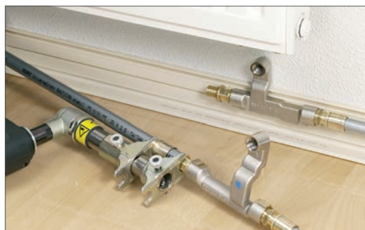
Рис. 16-34 Соединение с помощью подвижной гильзы, трубы диаметром 16 мм с крестовиной SL RAUTITAN из комплекта
