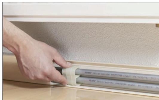
Рис. 16-36 Установка фиксаторов труб отопительной разводки
