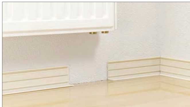
Рис. 16-42 Установленное основание плинтусного канала RAUSOLO с выемкой
