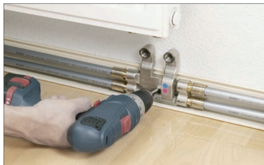
Рис. 16-35 Закрепление крестовины SL-RAUTITAN
