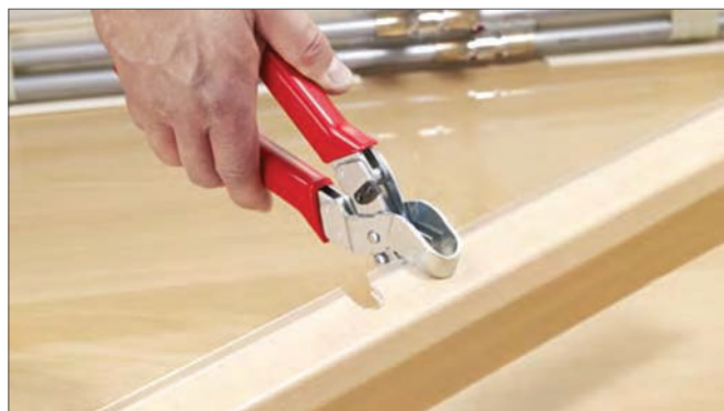
Рис.16-46 Вырезка полукруглых отверстий в крышке плинтусного канала
