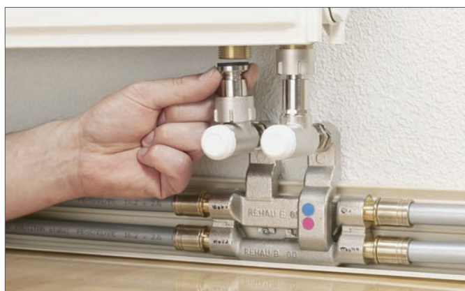
Рис. 16-26 Подключение угловых телескопических резьбозажимных соединений
