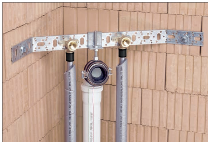
Рис. 5-3 Пример монтажа кронштейна
