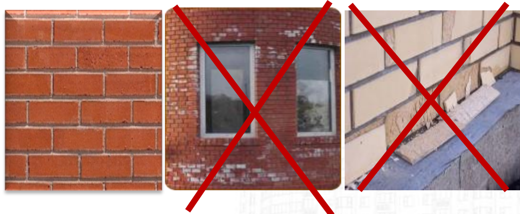
отсутствие высолов, разрушения кирпича
