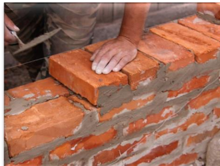
Возведения несущих элементов при кладке стен
