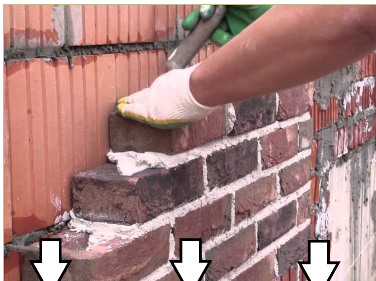
Кладка с одновременной расшивкой швов
