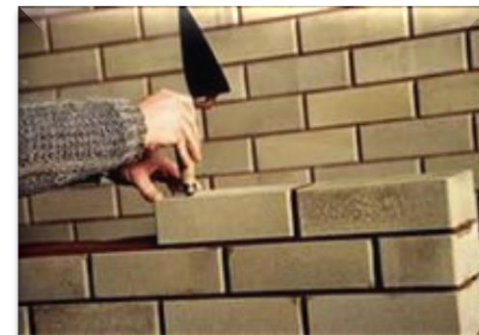
Возведения стен из облицовочного кирпича
